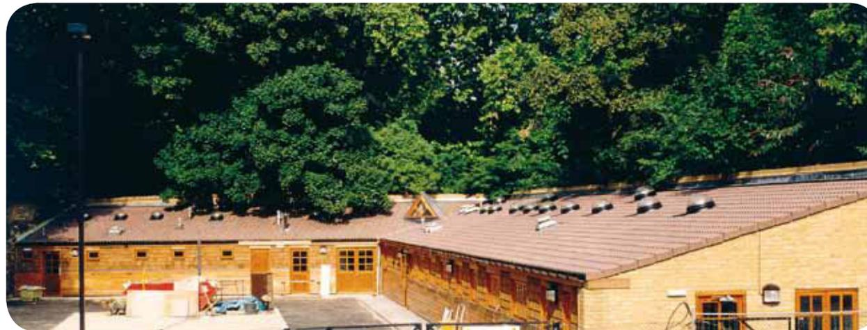
上：バターシーパーク警察署。監房、通路、面会室に 19 の 530mm 径 SUNPIPE 自然光システムを設置
